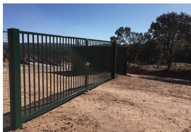
Portail avec barreaudage métallique vertical (crédit photo : Urbasolar)
