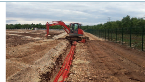
Création de tranchée pour enfouissement des lignes HTA (crédit photo : Urbasolar)
